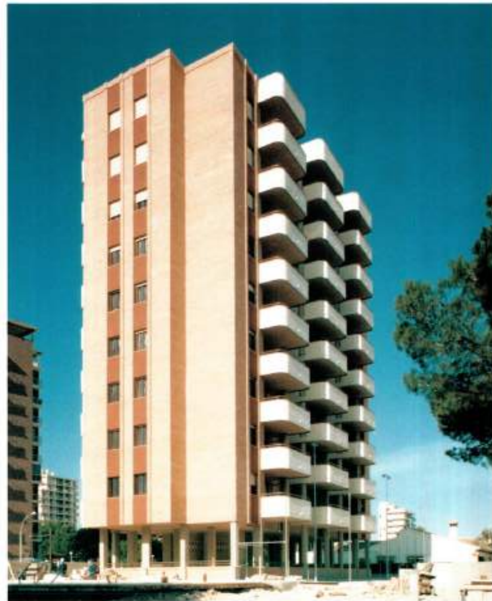
Edificio «Karibé», Playa de San Juan - Alicante.
